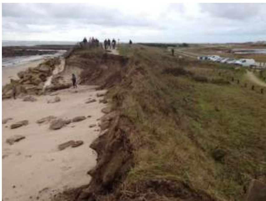
Disparition du chemin côtier et d'une grosse partie du cordon dunaire à l'est de la Pointe du Léhan (commune de Treffiagat) (photographie parue dans le télégrammes du 4 janvier 2014)
