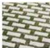
Paré en béton avec ouvertures de drainage
