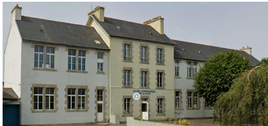
Rénovation école de Ste Marine
