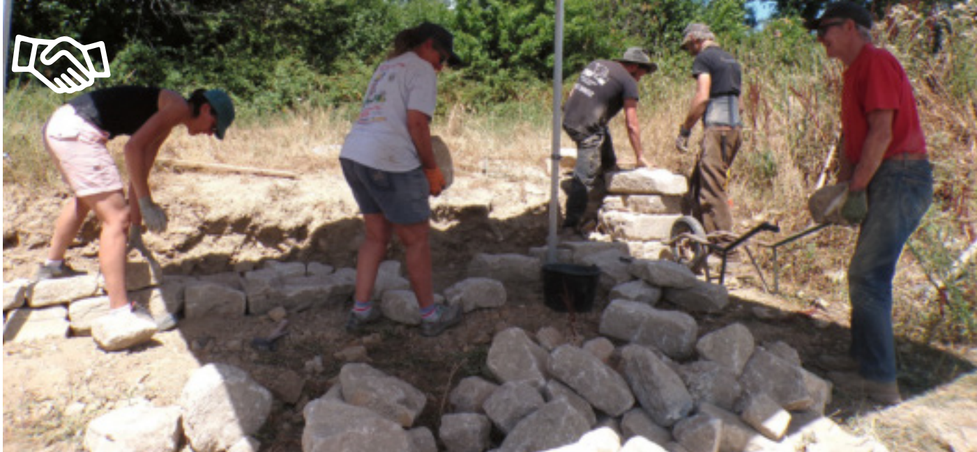
Les bénévoles s'activent pour construire 40 mètres de muret en pierres sèches.
